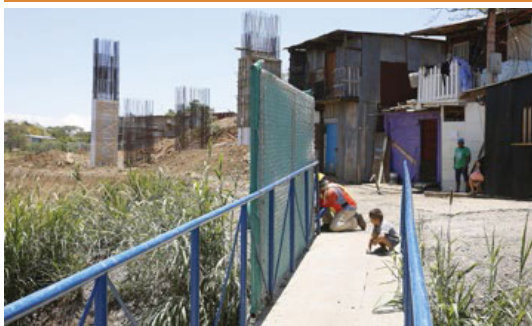
Obreros instalaron una malla que separa el Triángulo de Solidaridad de las obras del viaducto para Circunvalación. ALBERT MARÍN
