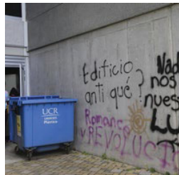
Así quedó ayer una parte del edificio de Ciencias Sociales de la UCR. RAFAEL PACHECO
