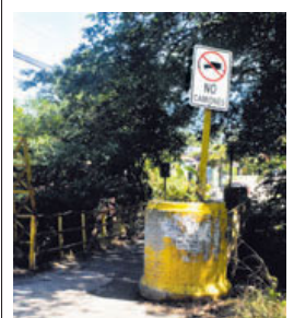
El puente fue afectado por la tormenta Nate. SHIRLEY VÁSQUEZ
