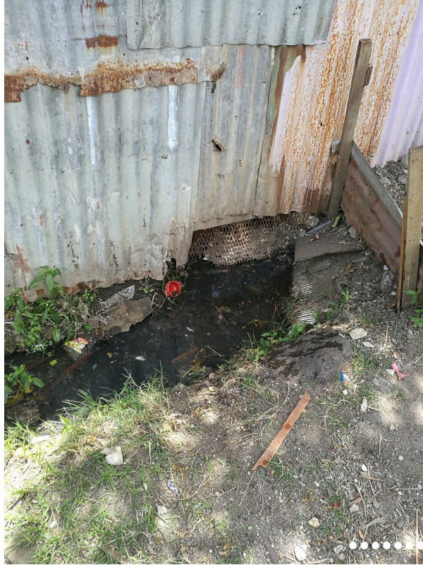
Proyecto habitacional Finca San Juan, etapa III. En Rincón Grande de Pavas.
