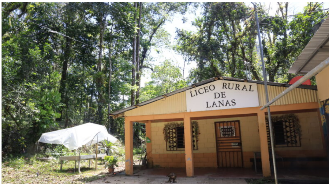
Esta es la infraestructura del colegio. • Isaac Villalta
